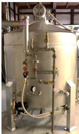
側面: 配管部分
